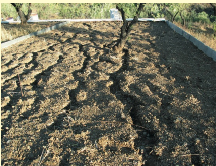
Erosión por surcos.
