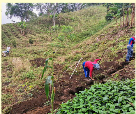
Acequias en construcción
