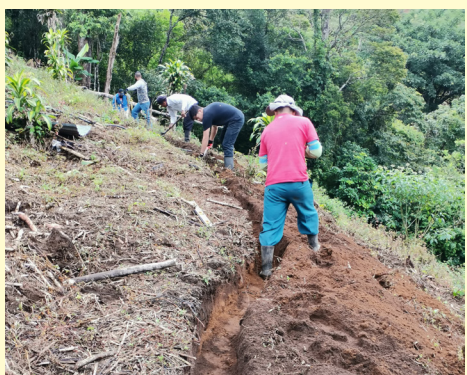
Construcción de acequia y caja de sedimentación
