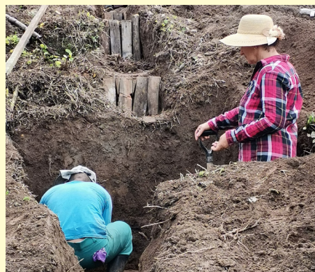
Construcción de caja de sedimentación
