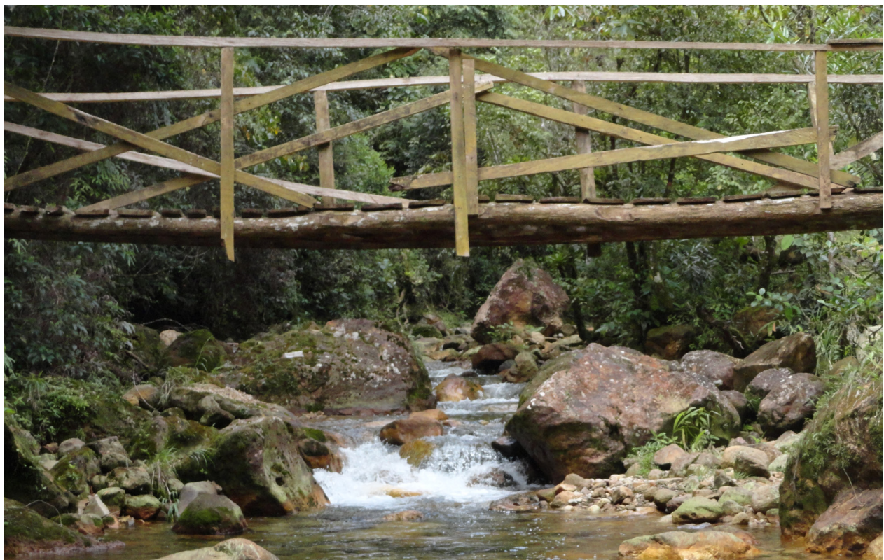
Puente sobre el río Gallito, en la parte alta de la microcuenca; es utilizado por residentes de las comunidades de Piura, La Fondura, entre otras. E. Gonzalez diciembre 2013.
